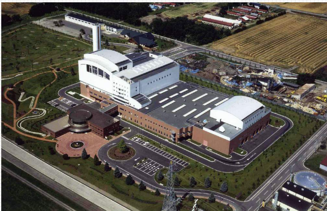
帯広ごみ処理施設「くりりんセンター」
