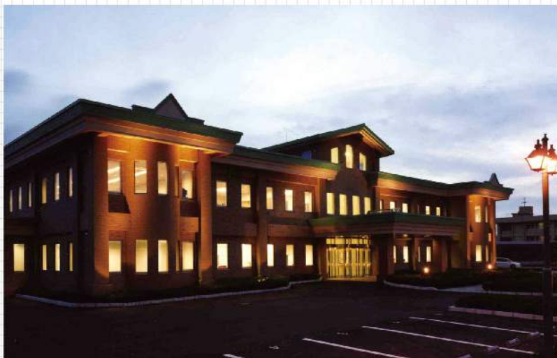
函館少年刑務所庁舎外観〔夜景〕
