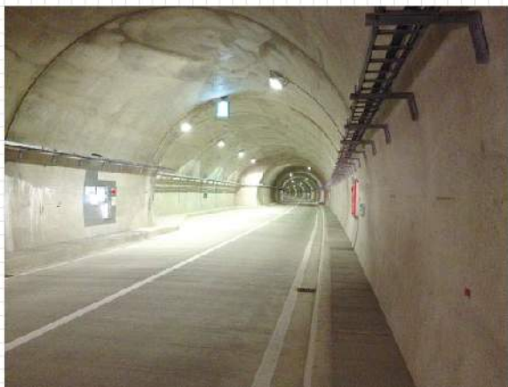
太田トンネル
