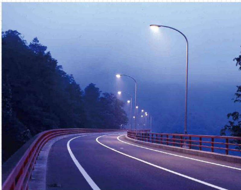
小樽定山溪線道路設備工事
