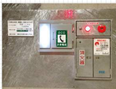
太田トンネル
