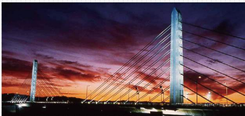
旭川東光大橋
